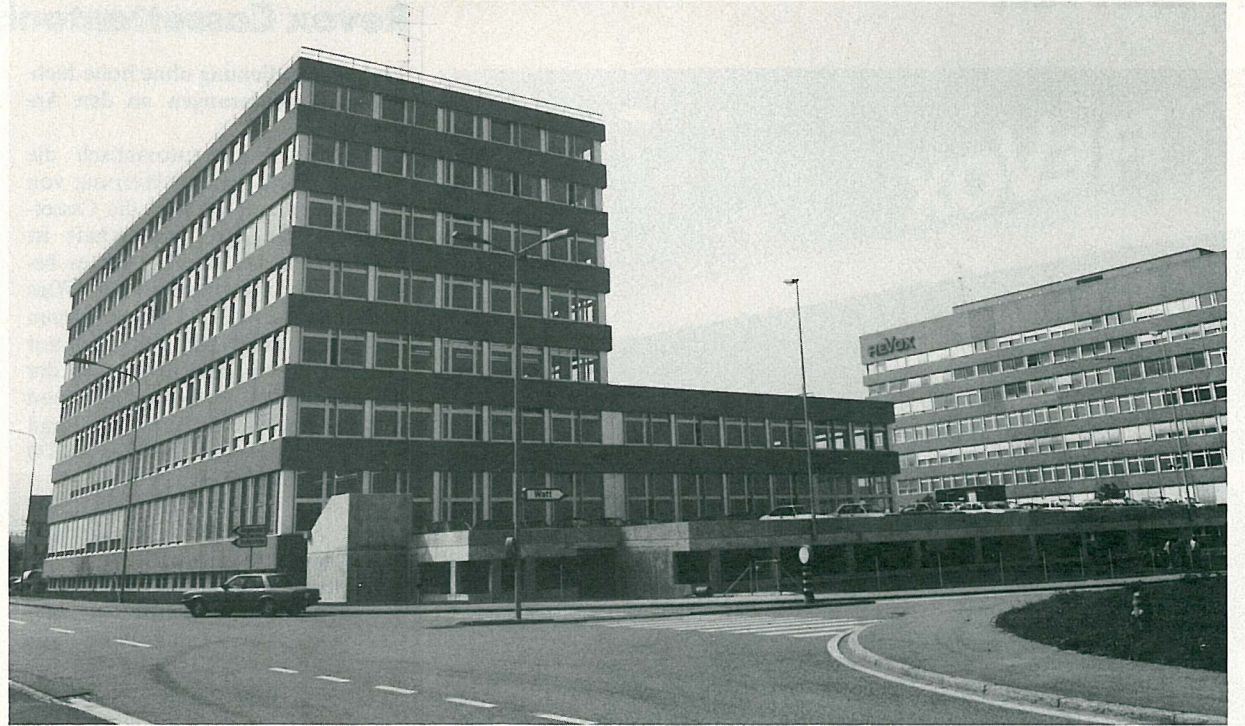
Links der jetzt bezogene Neubau an der Althardstrasse 10, rechts daneben das bestehende Gebäude an der Althardstrasse 30.
